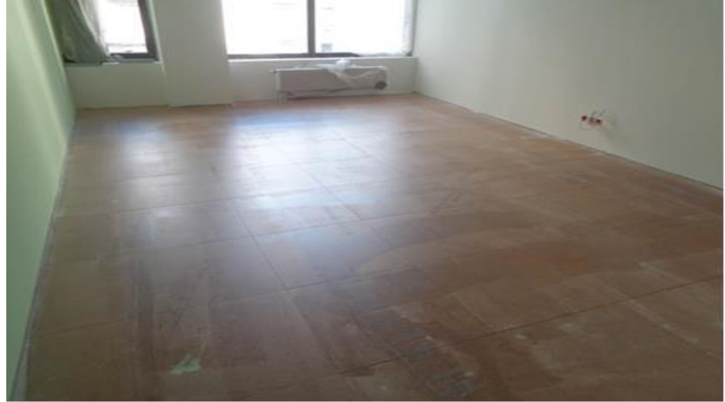
Ragasztó felhordása, burkolat fektetés előtt
